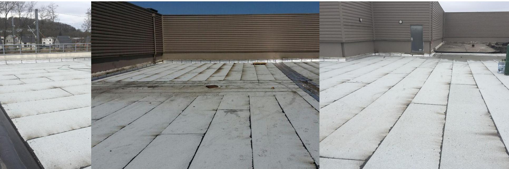
Etanchéité bicouche bitumineuse d'un centre commercial
